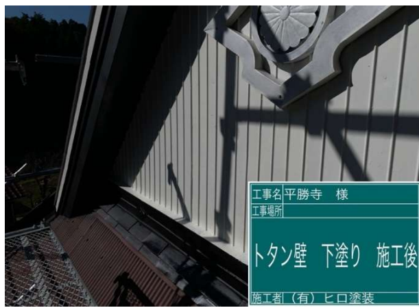
14 トタン白壁 下塗り 施工完了
