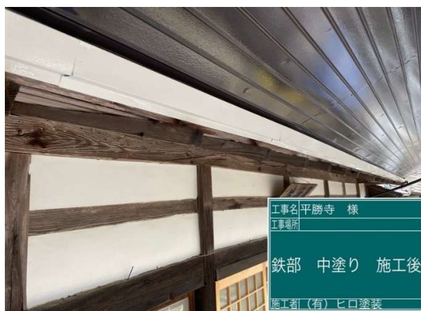
26 水切り 中塗り 施工完了
