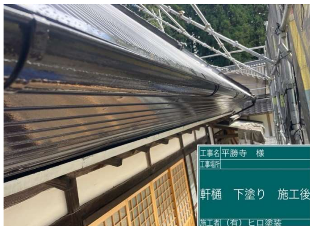
20 雨樋 下塗り 施工完了
