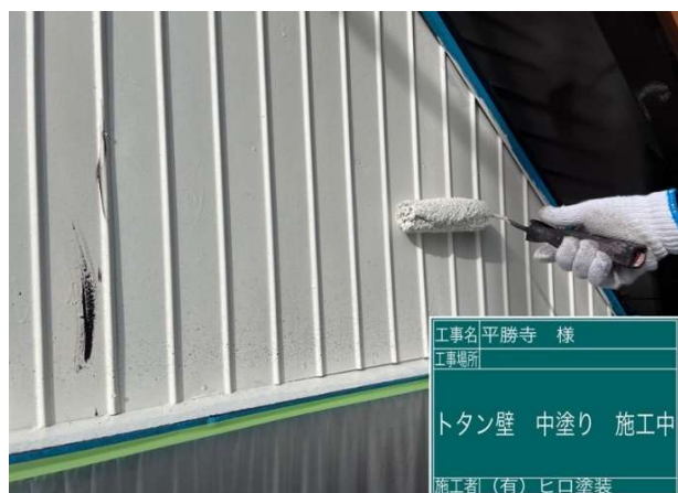
15 トタン白壁 中塗り 施工中
