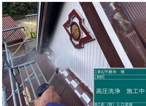
2 高圧洗浄 施工中
