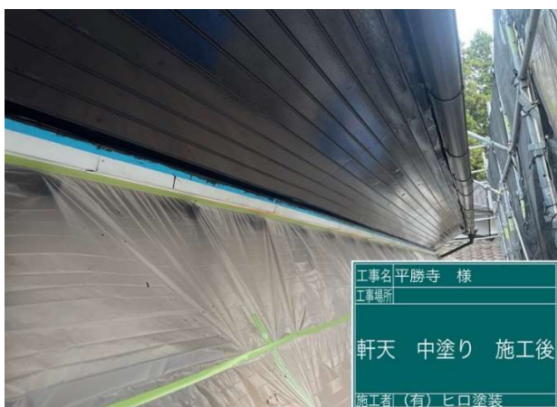
10 軒天 中塗り 施工完了
