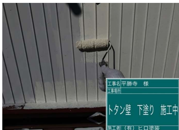
13 トタン白壁 下塗り 施工中
