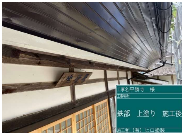
28 水切り 上塗り 施工完了
