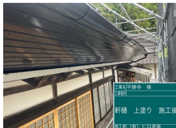
22 雨樋 上塗り 施工完了
