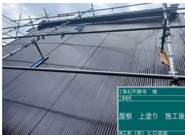
8 屋根 上塗り 施工完了
