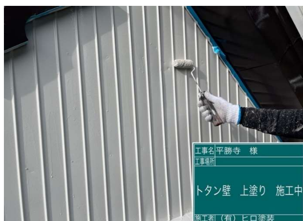
17 トタン白壁 上塗り 施工中
