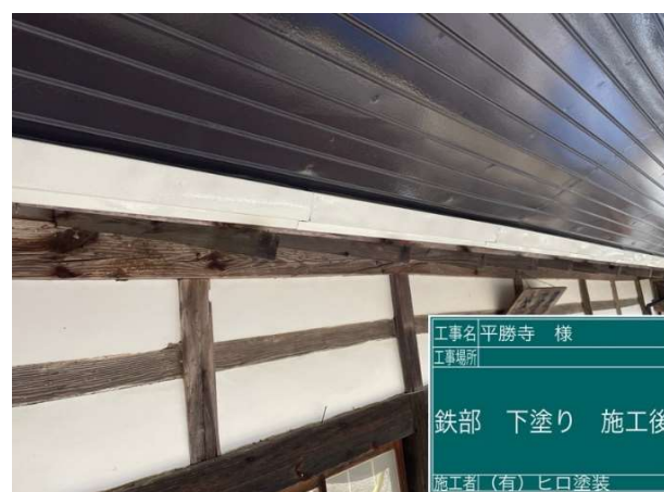
24 水切り 下塗り 施工完了
