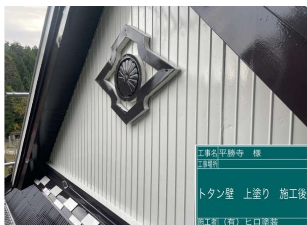
18 トタン白壁 上塗り 施工完了
