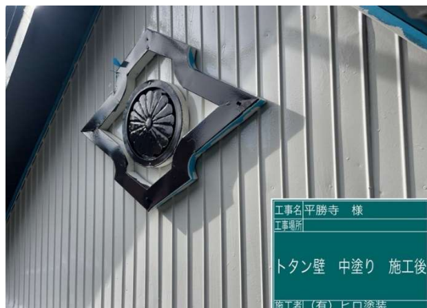
16 トタン白壁 中塗り 施工完了
